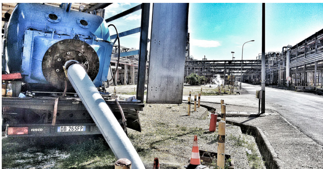
CIPP: Sistema di inversione ad aria - dettaglio del tamburo ad inversione
