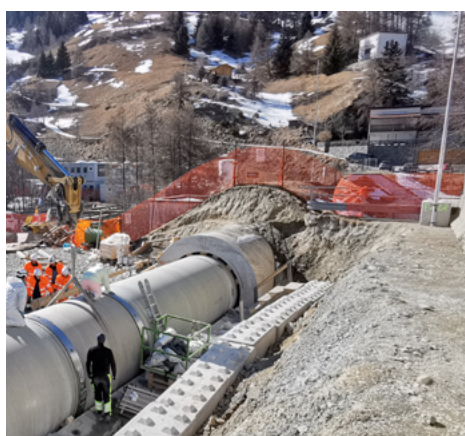
Cantiere Rotech a San Valentino alla Muta (Alto Adige)
