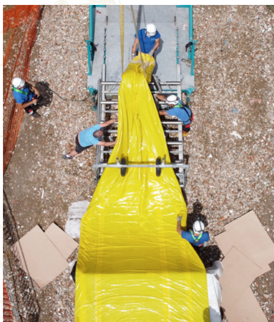
Cantiere relining, inserimento del liner all'interno della condotta
