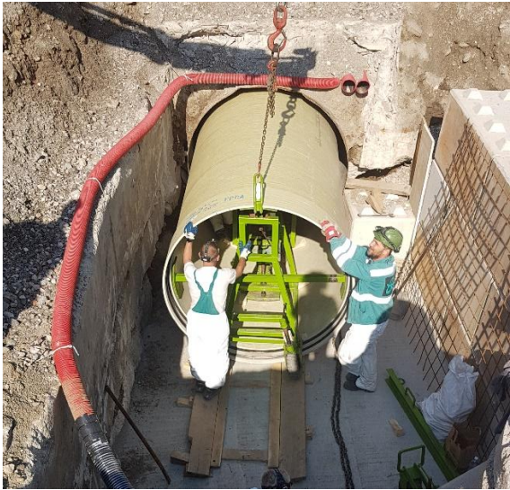
Figura 7:Carrello per l'inserimento dei tubi
