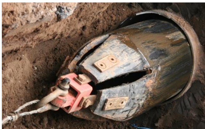
Figura 5: Attacco al tubo (testa di tiraggio)
