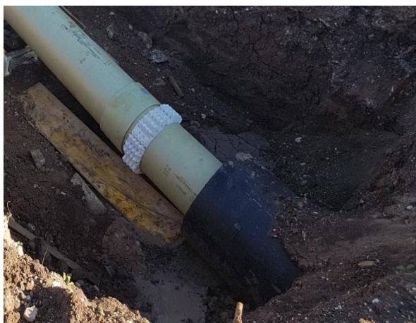
Figura 8: Esempio di ausilio per l'installazione "pattini"
