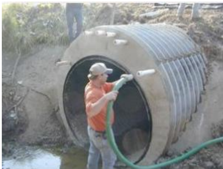
Figura 13: Bocchettoni di ventilazione nel punto più alto
